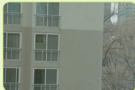
단열재 설치 후
