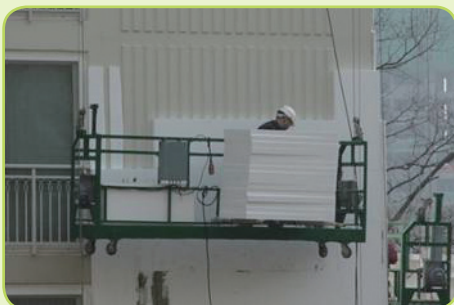
단열재 추가 설치 공사
