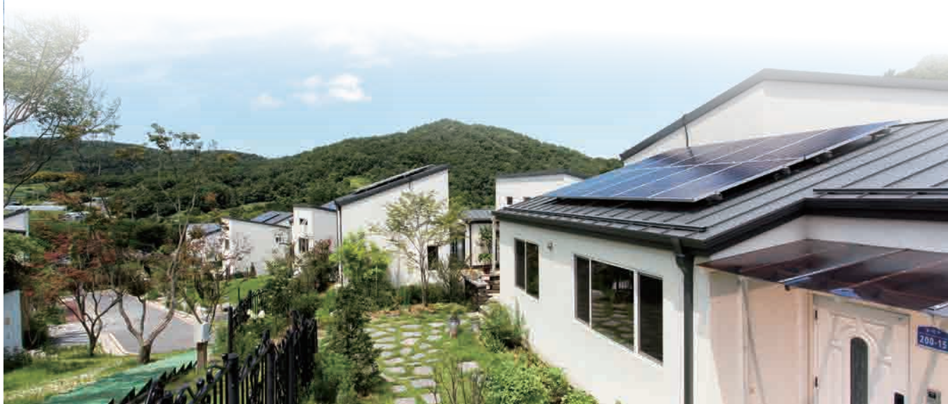
충남 아산 예꽃재마을의 32가구 지붕에는 태양광 패널이 설치됐다. 태양광을 이용해 전기를 생산하고 지열보일러로 물을 데워 난방과 온수를 해결한다. 예꽃재마을은 재생에너지를 사용한 덕에 에너지 자립률 80%를 달성했다. IC영상미디어
