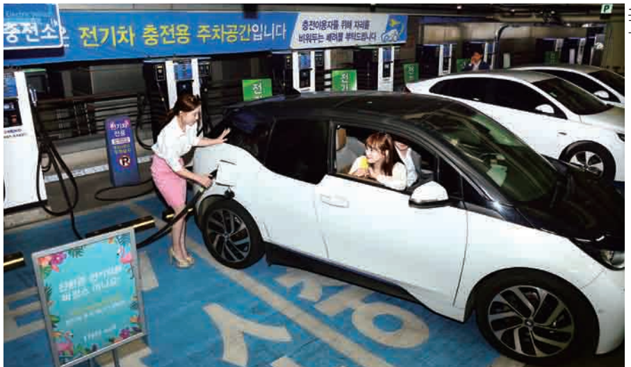
지난 6월 서울 용산구 아이파크몰에 설치된 전기차 충전소. 정부는 전기차·수소차의 획기적 보급 확대를 통해 자동차-ICT 융합 플랫폼을 구축한다는 계획이다.
