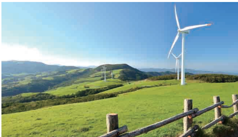
2006년 대관령삼양목장에 설치된 풍력발전단지. 대관령 일대는 태백산맥을 중심으로 한 해발 900m 이상의 고산 지대이자 바람이 많고 서남풍이 초속 6~7m로 일정하게 불어 풍력발전단지 최적의 장소로 주목받았다.
