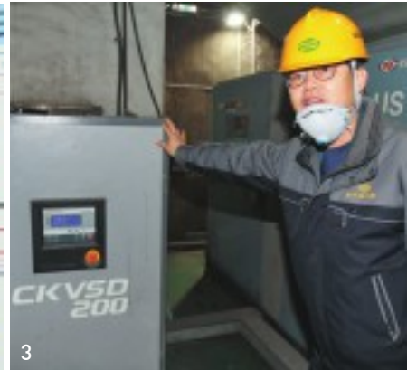
1 경기도 안산시 시화공단에 위치한 성림유화 전경 2 김상호 공장장이 2020년 정부의 '탄소중립설비 지원사업'으로 설치한 폐열회수 설비의 원리를 설명하고 있다. 3 성북경 부장이 2015년 정부의 '탄소중립설비 지원사업'으로 구형 공기압축기에 설치한 외장형 인터버의 장점을 설명하고 있다.
